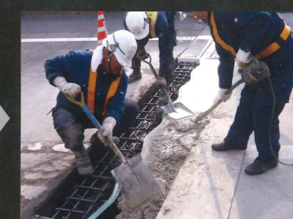
05 コンクリート打設
