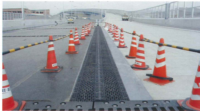
501工区高架橋 (福岡)
