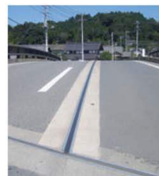
完成(縦目地での採用例)
