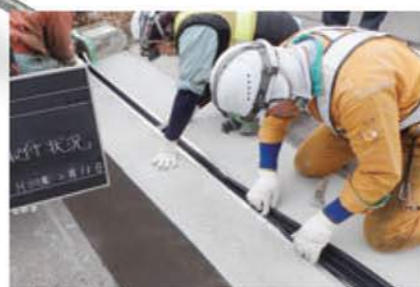
止水ゴム交換作業
