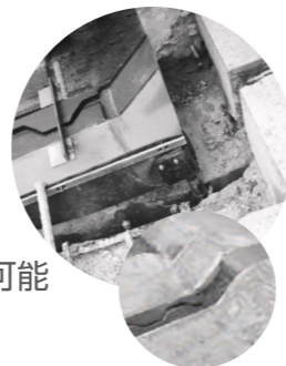
▲地覆ジョイント施工例
